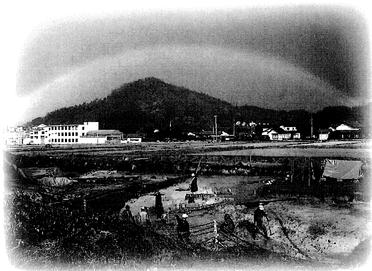
雨乞山と前田遺跡の発掘現場 [松江市提供]
